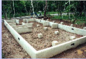
鉄筋コンクリート布基礎
