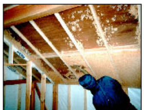
天井に吹き付け式断熱材
